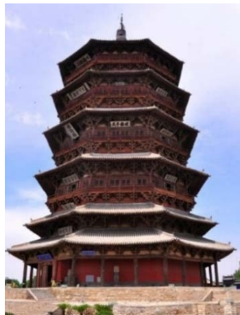
图 1 应县木塔实景图
